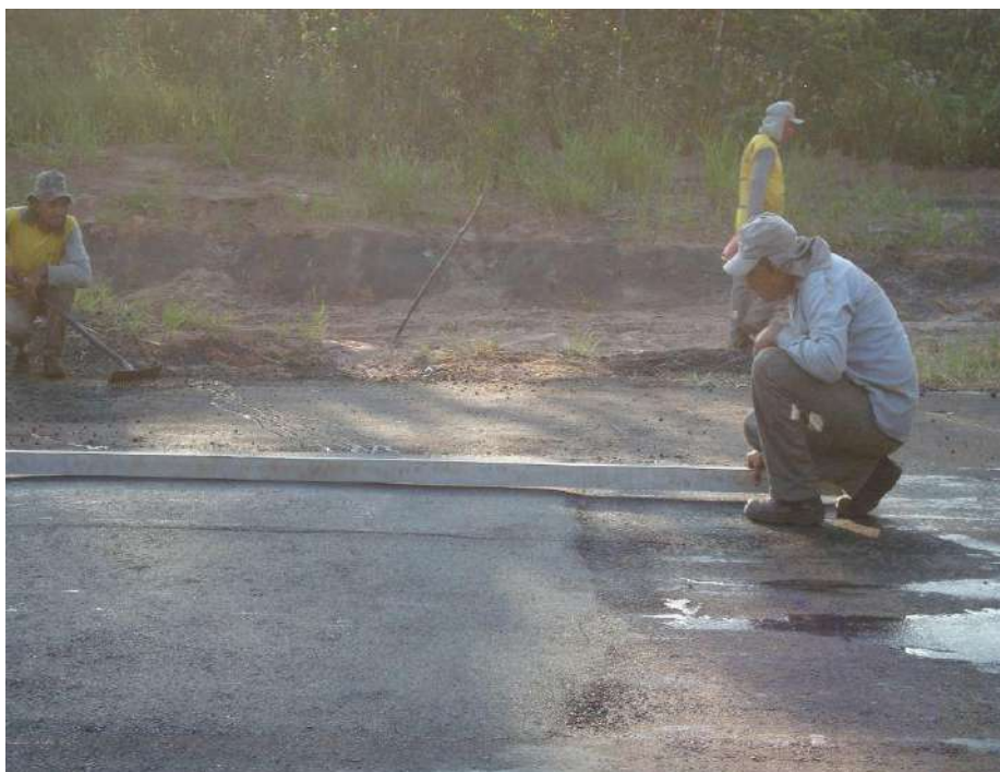
Figura 4: Exemplo de régua para controle de acabamento de superfície.
