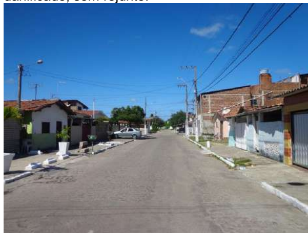
Foto 4 – Trecho com tapa buracos.
