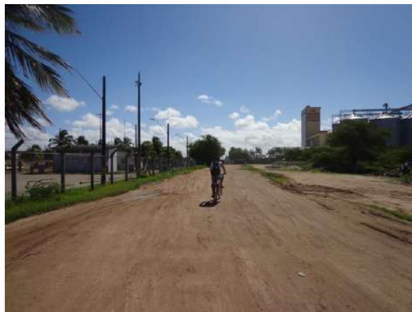
Foto 2 – Trecho sem pavimentação.
