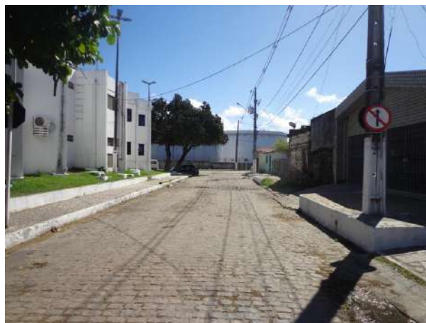
Foto 2 – Afundamento da trilha da roda externa.
