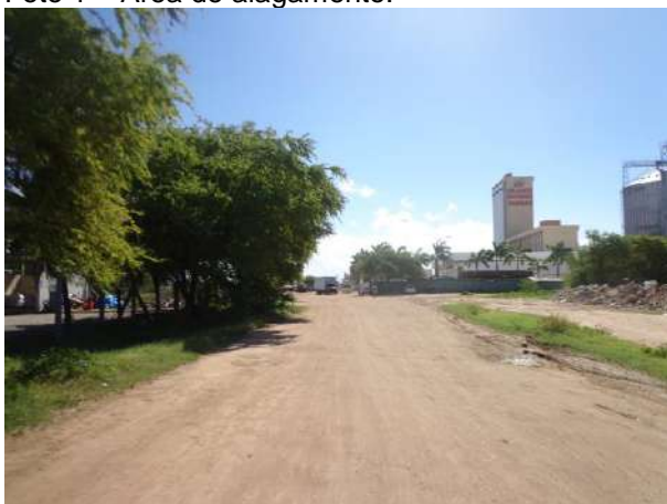
Foto 3 – Trecho sem pavimentação.
