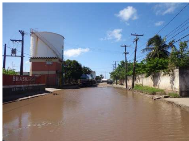
Foto 4 – Área totalmente destruída, com afundamentos e totalmente alagada no período chuvoso.
