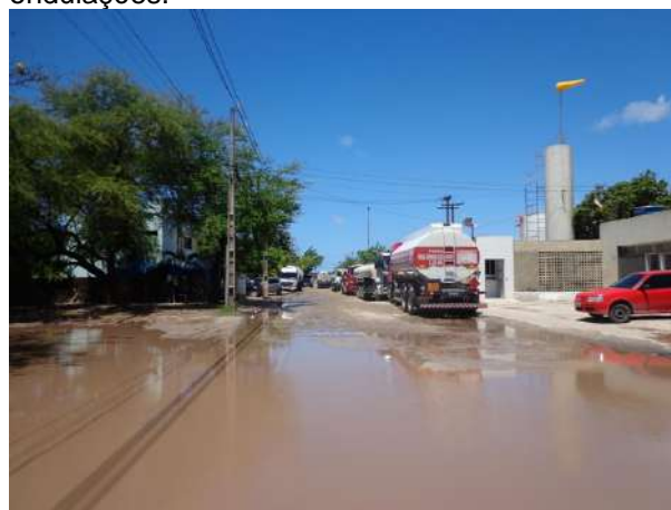
Foto 4 – Área de alagamento.
