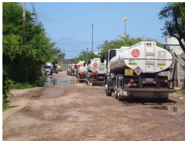
Foto 2 – Trecho destruído, com muitas ondulações.
